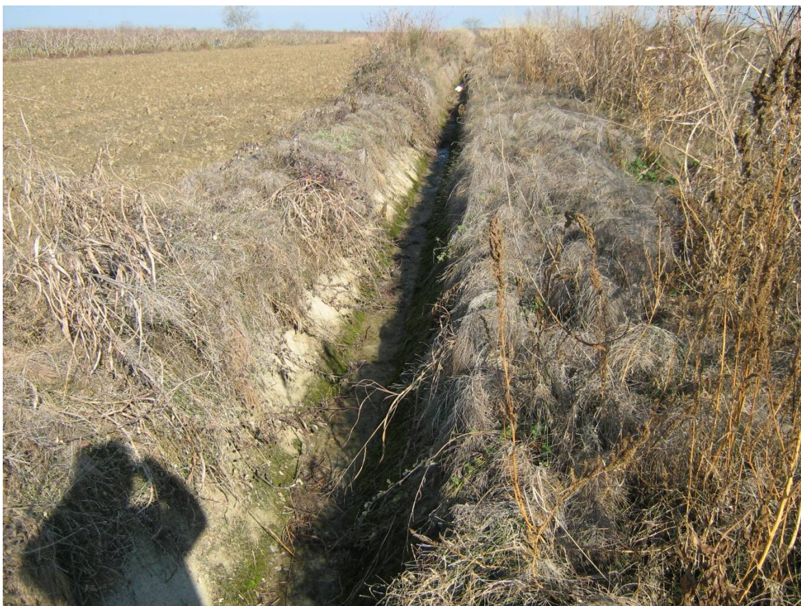
Εικόνα 3 Τσιμενταύλακας αριστερής πλευρά και εναποθέσεις
