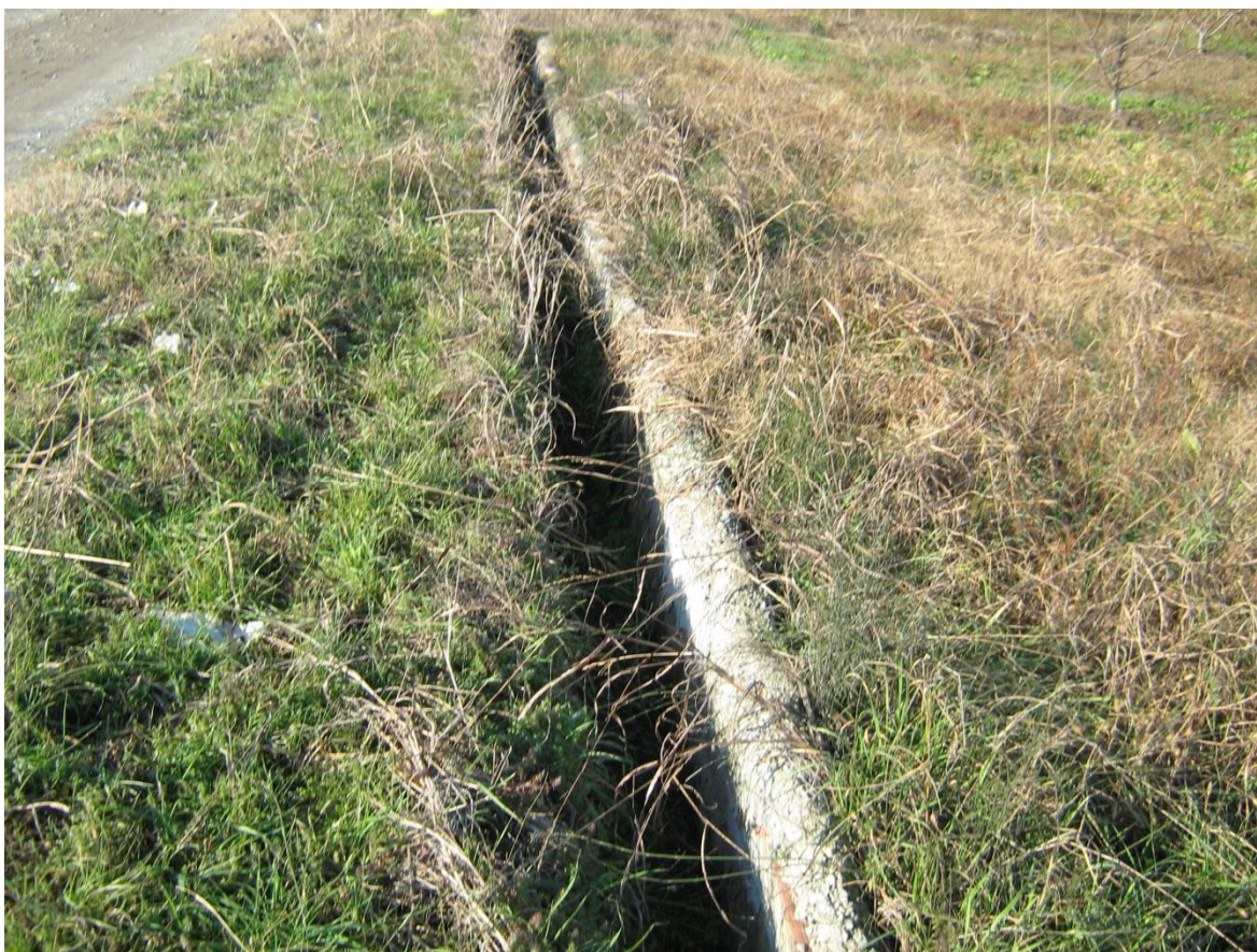
Εικόνα 4 Τσιμενταύλακας δεξιάς πλευράς και εναποθέσεις
