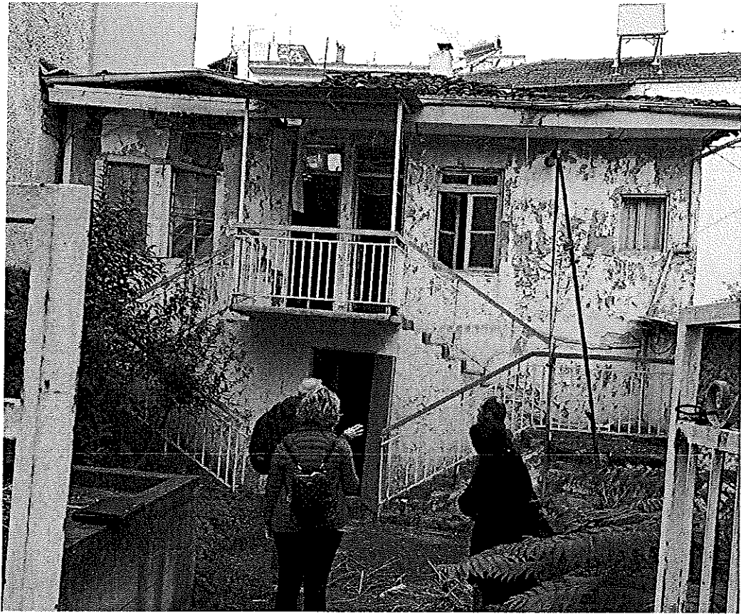
Φωτ. 3 Πρόσοψη του κτίσματος
