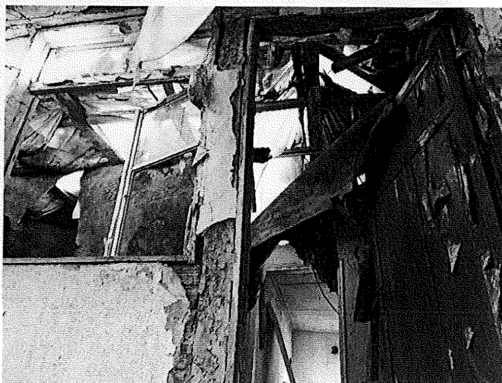
Φωτ. 7 Όροφος τμήματος Α
