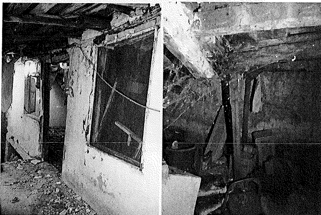
Φωτ. 5 Αριστερά ο όροφος του τμήματος Α και Φωτ.6 Δεξιά Το εσωτερικό του ισογείου του τμήματος Β
