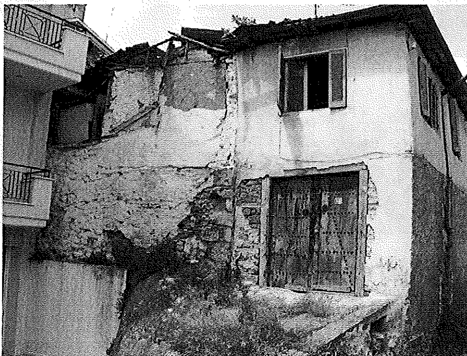
Φωτ. 3 Νότια όψη
