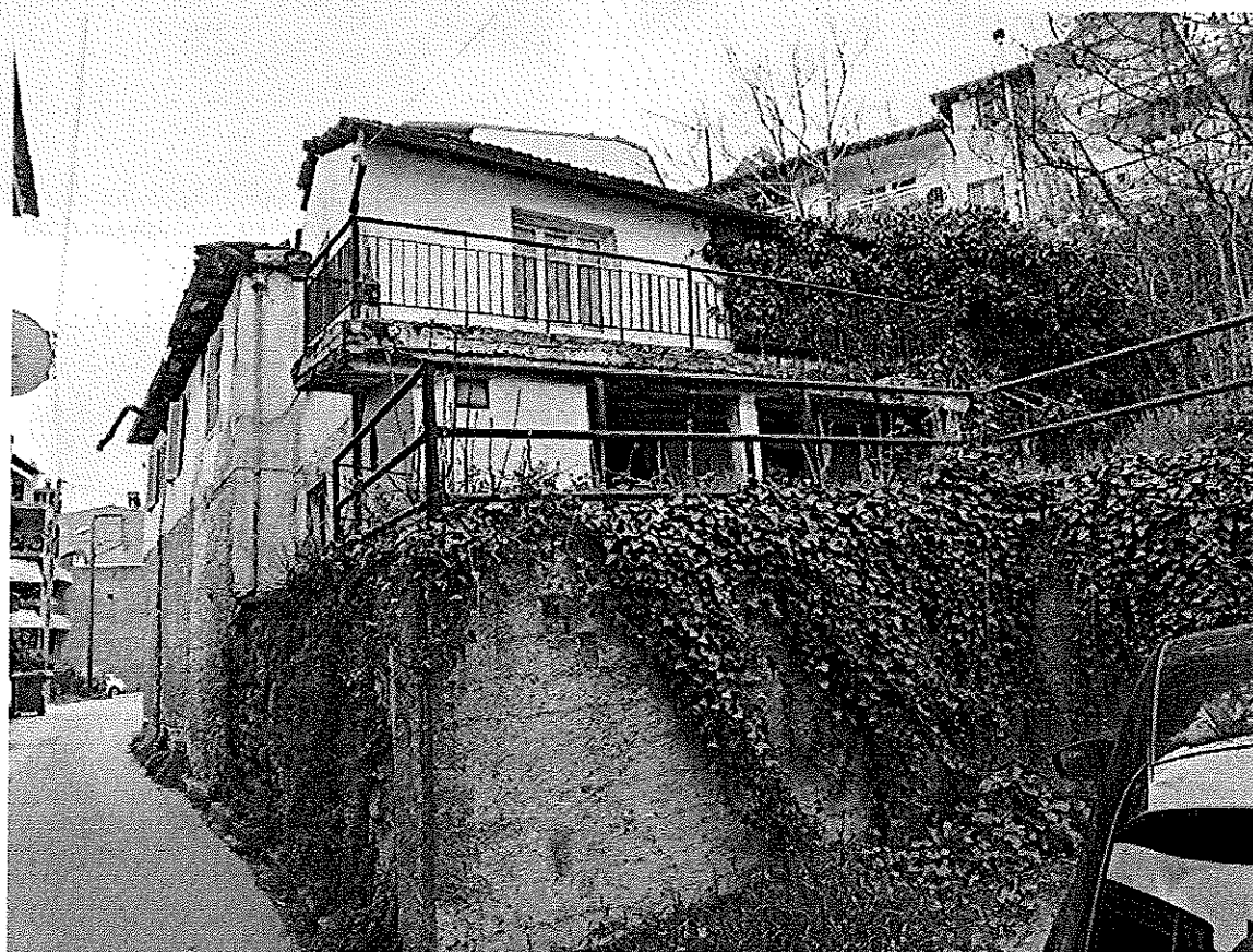
Φωτ. 9 Βόρεια όψη
