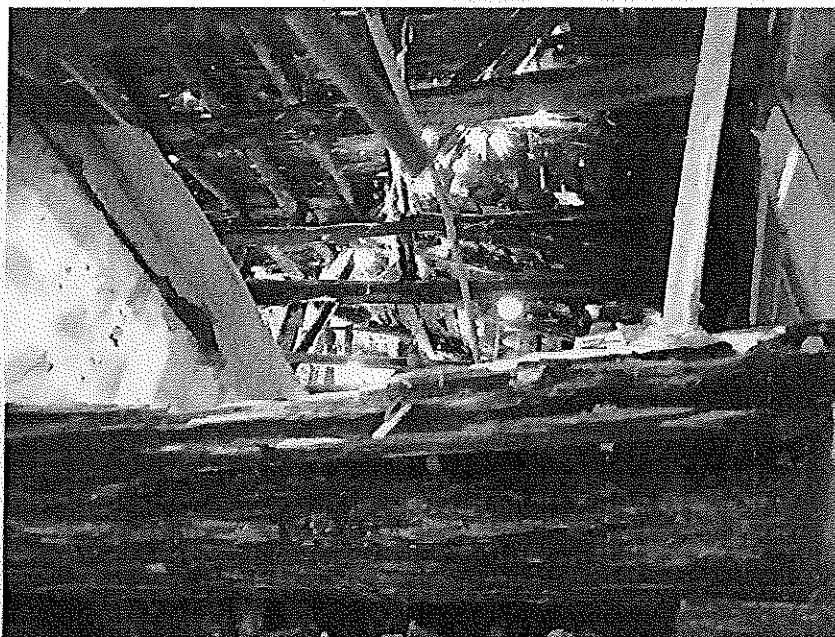
Φωτ. 8 Όροφος τμήματος Β
