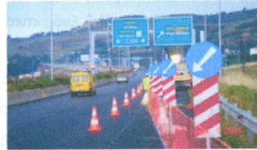
Εικόνα 4.4: Προστατευτικό πλέγμα ασφαλείας για περιοχές εκτέλεσης έργων
