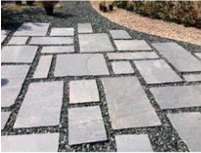
Εναλλαγή δαπέδου από πλάκες γρανίτη και κροκάλα σε σκυρόδεμα
