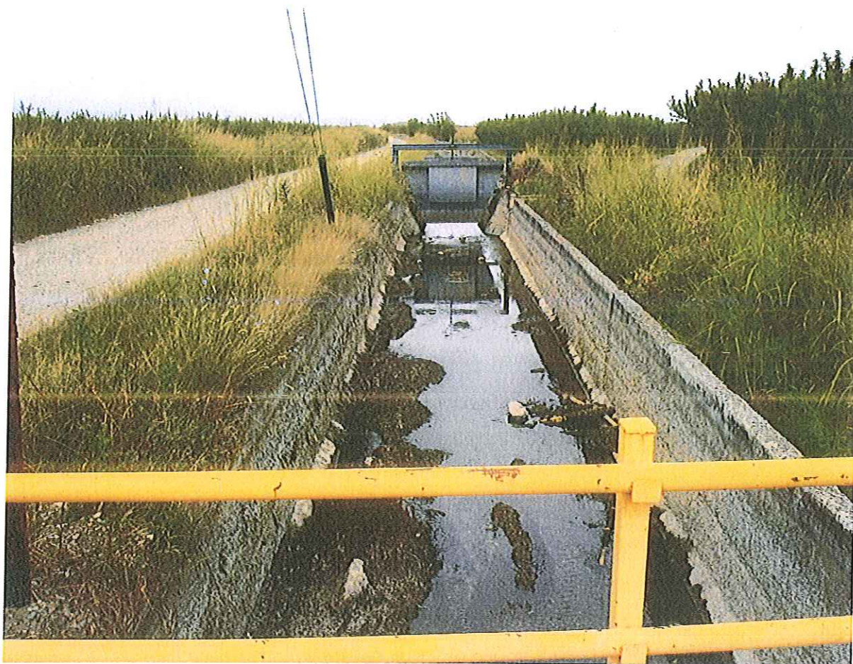
Εικόνα 2 Χαρακτηριστική φωτογραφία δεξιάς πλευράς
