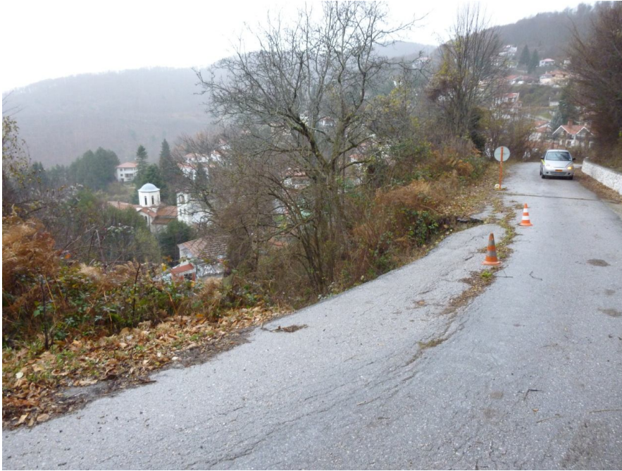
Φωτ 1.1: Άποψη της οδού εντός οικισμού Καστανιάς, όπου διακρίνεται η καθίζηση και οι εφελκυστικές ρωγμές που προκλήθηκαν από το φαινόμενο της ολίσθησης.
