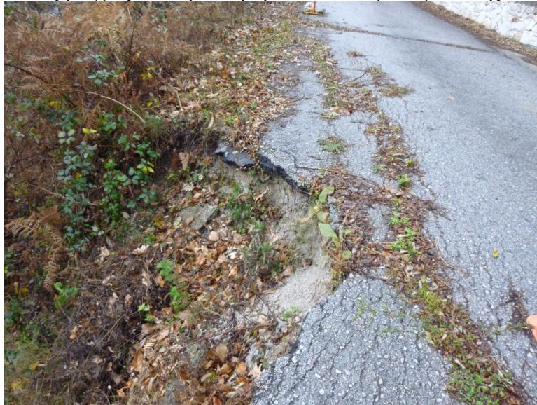
Φωτ 1.2: Άποψη της οδού εντός οικισμού Καστανιάς
