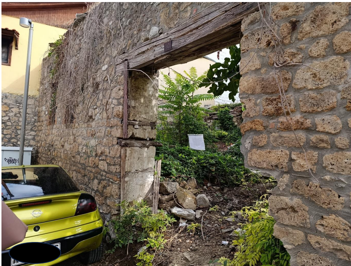
Φωτ 6 Λεπτομέρεια λιθοδομής περιτοίχισης-είσοδος στο οικόπεδο
