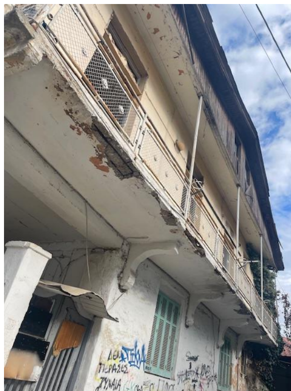
Φωτ 3 Αριστερά λεπτομέρεια ορόφου όπου διακρίνεται η μεταγενέστερη προσθήκη και η γειτνίαση με το διατηρητέο και Φωτ. 4 Δεξιά λεπτομέρεια εξώστη με εμφανή διάβρωση υλικών
