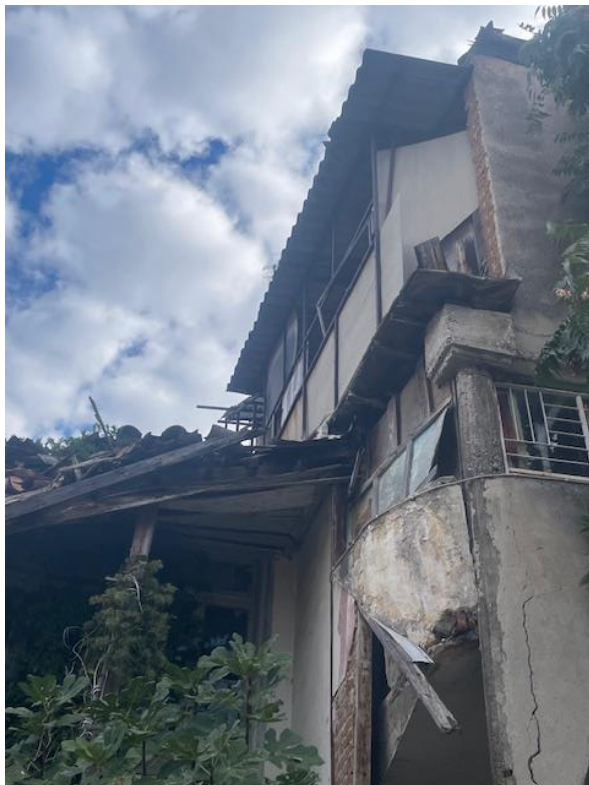
Φωτ 3 Αριστερά λεπτομέρεια ορόφου όπου διακρίνεται η μεταγενέστερη προσθήκη και η γειτνίαση με το διατηρητέο και Φωτ. 4 Δεξιά λεπτομέρεια εξώστη με εμφανή διάβρωση υλικών
